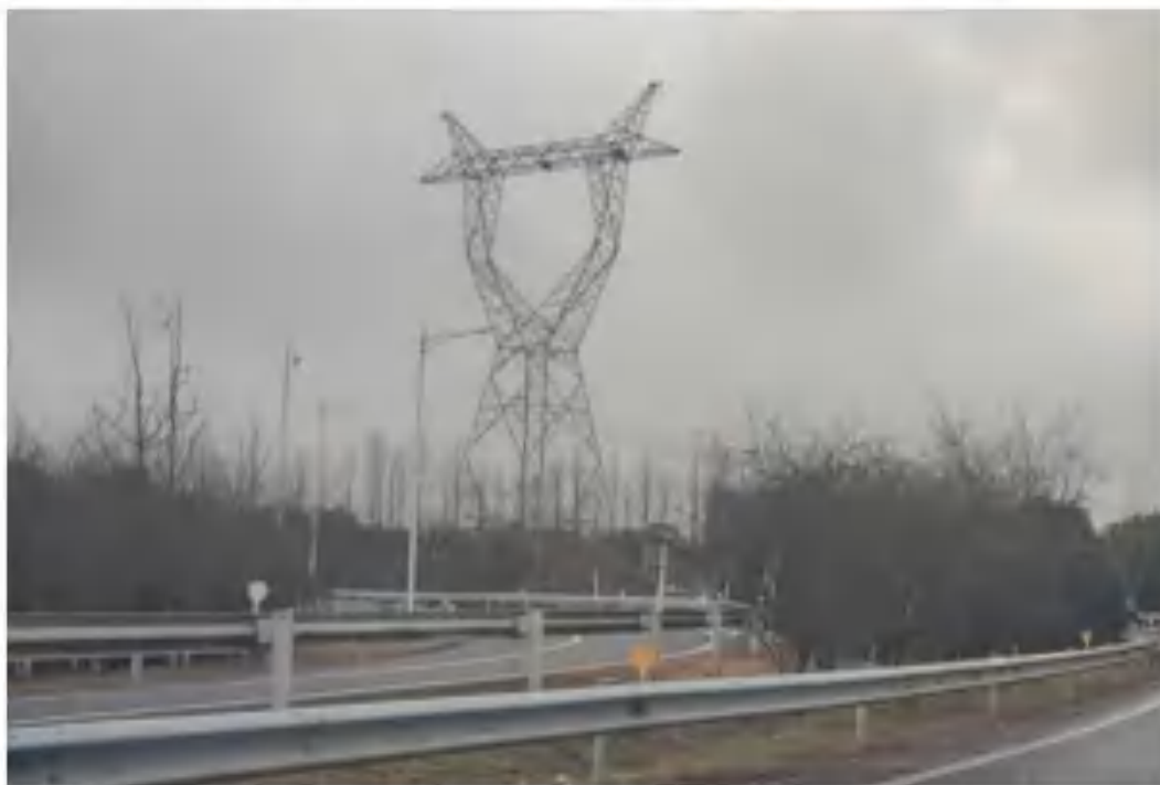
图 3.2-2 输油管道迁改终点处现状电塔（电缆已改线）
