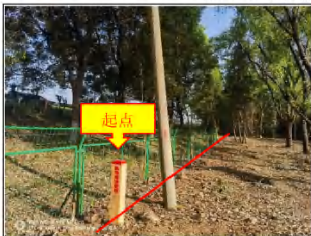
图 3.1-2 拟改迁段管道起点现状图
