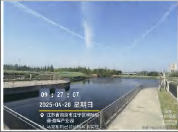
图 4.4-15 水塘（定向钻穿越水体）
