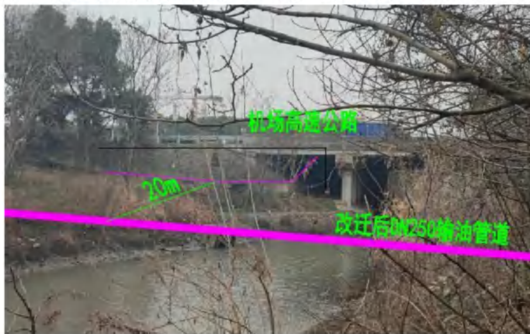
图 3.2-3 输油管道穿越新丰渔场桥现状图
