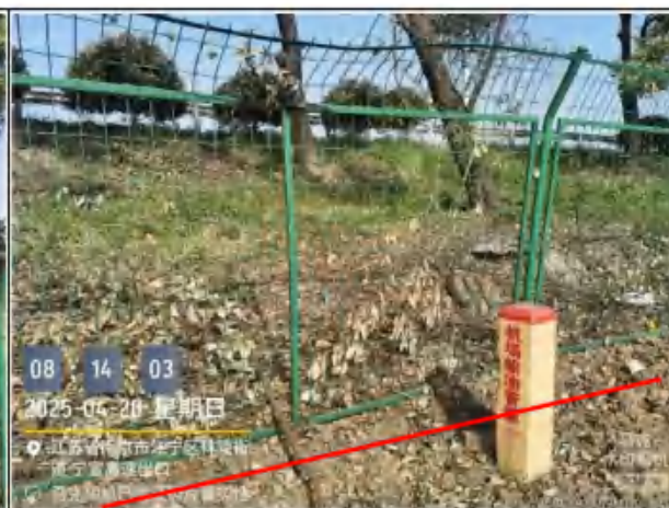
图 3.1-5 拟改迁段管道现状图
