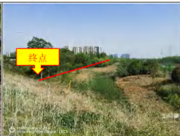
图 3.1-3 拟改迁段管道终点现状图
